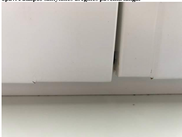
8pav. Patalpos santykinės drėgmės paveikti langai
