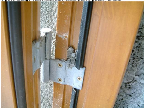
6 pav.: Lango varstymui statybinio purvo padaryta žala
