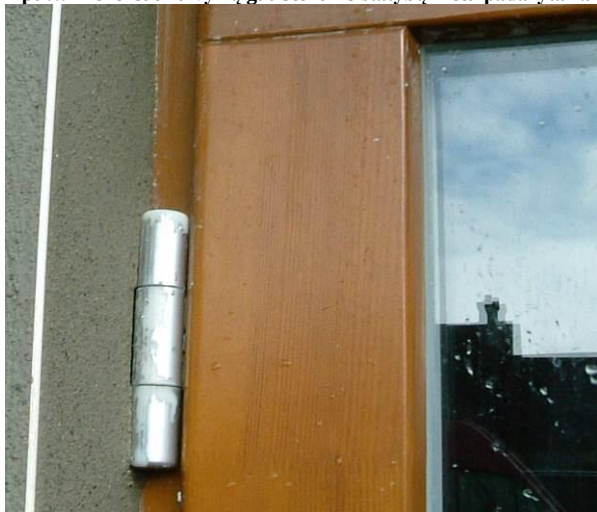
7 pav.: Nickel satina vyrių gaubteliams statybų metu padaryta žala
